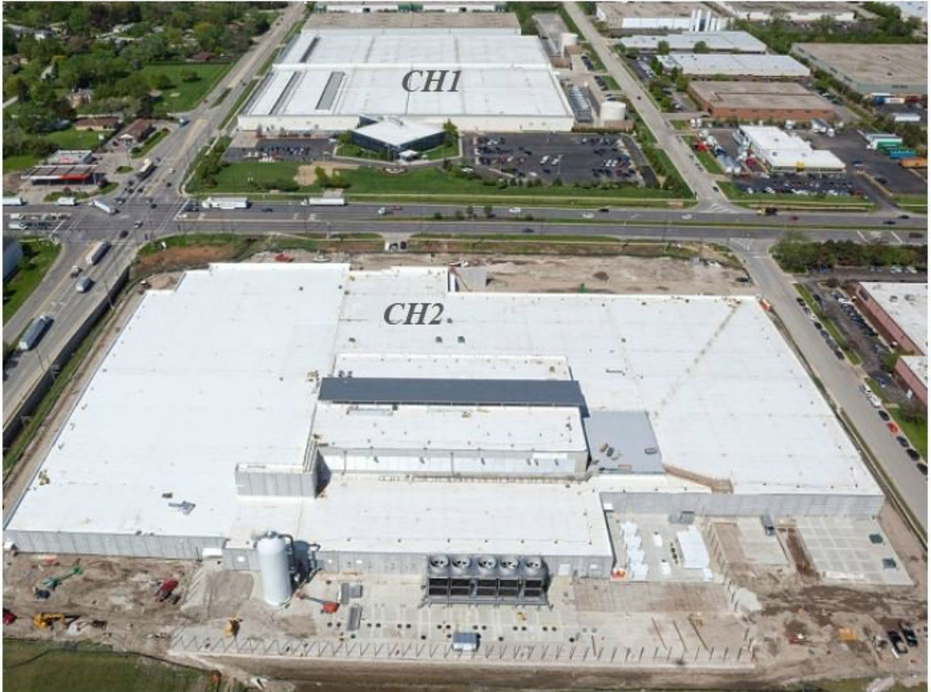
CH2 Data Center Elk Grove Village, IL
